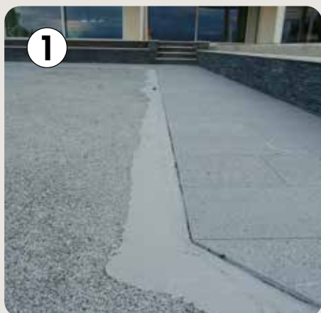
Béton avec gravillons & lit de mortier
